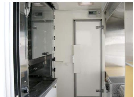
Direkter Zugang zum Kühlraum
